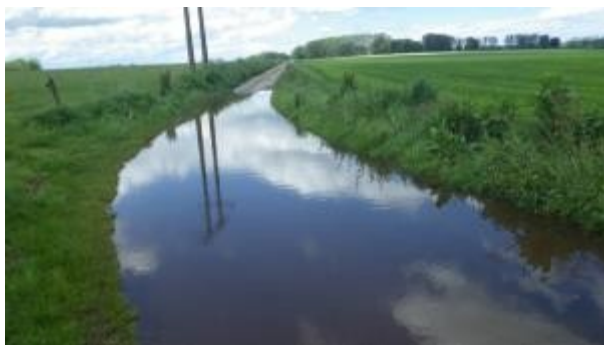
Photographie 5 : Inondation par stagnation d'eau dans une voirie
